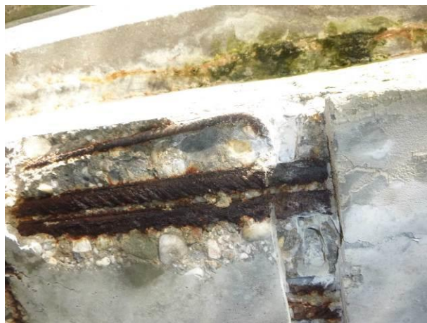
Pohled na stav výztuže. Obnažená korodující krajní výztuž.
