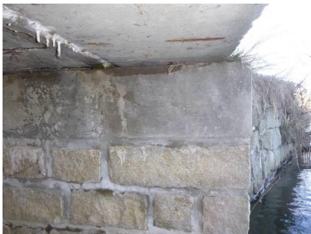
Pohle na ÚP pravobřežní opěry. Železobetonový práh je bez výrazných poruch.
