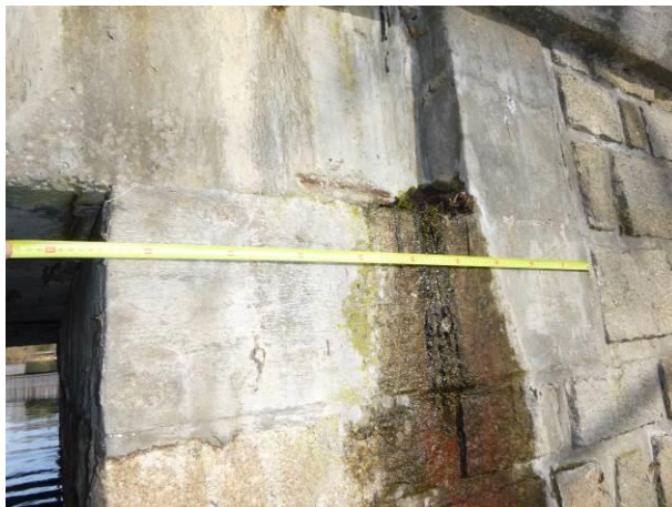
Pohled na povodní levé rovnoběžné křídlo. Viditelné zatékání z mostního svršku.
