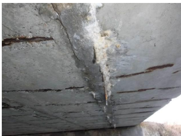
Pohled na inkrustaci mezi jednotlivými nosníky od zatékání z mostního svršku.
