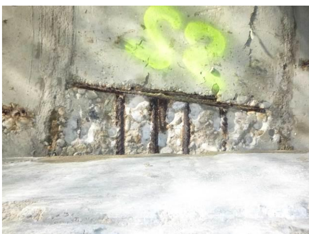
Pohled na výztuž u podpory. Krycí vrstva chybí.
