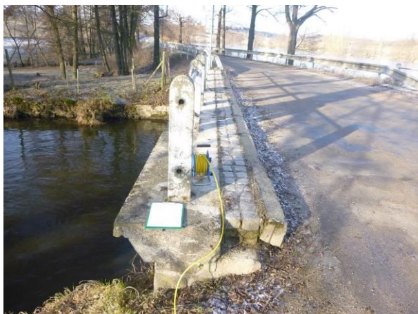
Pohled na povodňovou stranu. Viditelně chybějící žulová dlažba, obruba je deformována.
