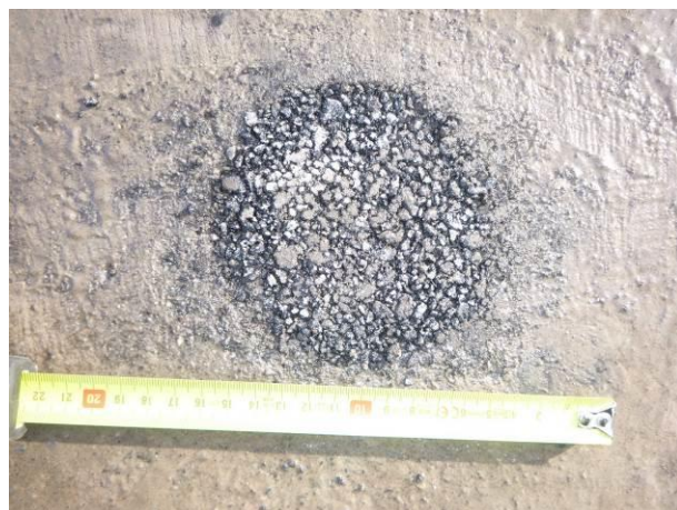
Pohled na zapravení sondy studenou asfaltovou směsí.
