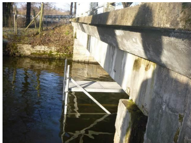
Boční pohled na monolitickou železobetonovou římsu.
