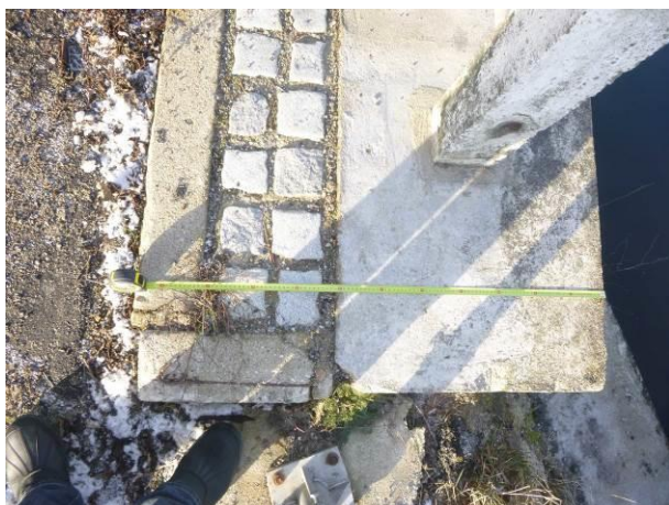
Pohled na železobetonovou římsu, betonovou obrubu a dvě řady žulových kostek.
