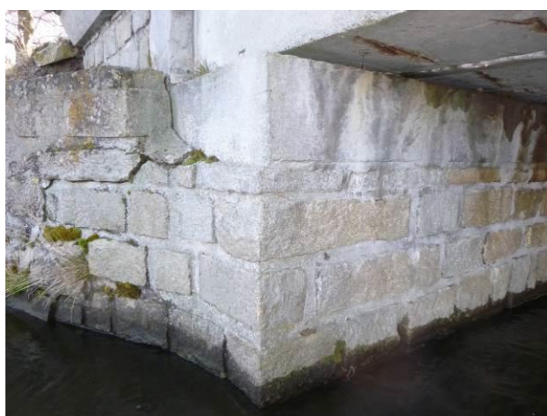
Pohled na návodní levé šikmé křídlo. Viditelné uvolněné kamenné bloky, chybí spárová cementová malta, prorůstá vegetace.
