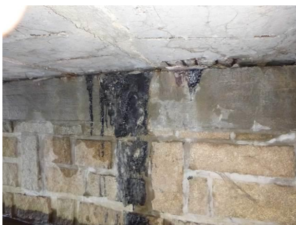
Detailní pohled na ÚP, viditelná roztečená živičná izolace, na kterých jsou pravděpodobně uloženy nosníky.
