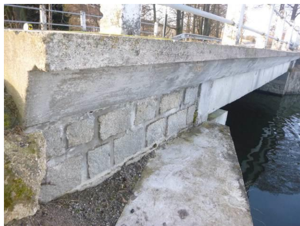
Boční pohled na monolitickou železobetonovou římsu.
