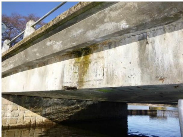
Pohled na nosnou konstrukci tvořící plně prefabrikovan nepředpjaté železobetonové nosníky a pohled na monolitickou římsu.
