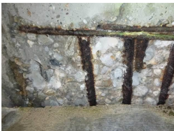
Detailní pohled na korodující výztuž.
