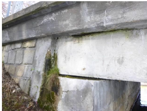
Pohled na povodní pravé rovnoběžné křídlo. Viditelné zatékání z mostního svršku. Viditelné prorůstání vegetace.
