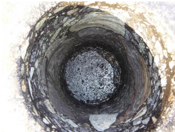
Pohled do vývrtu, viditelná izolace mostovky.
