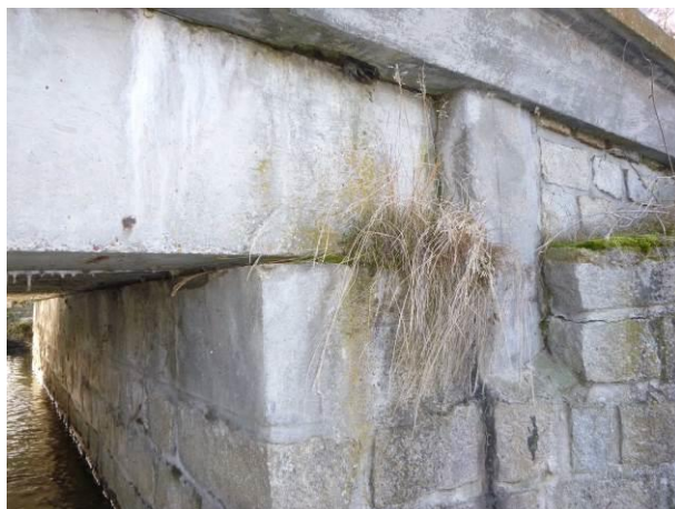
Pohled na návodní pravé šikmé křídlo. Chybí spárová cementová malta, prorůstá vegetace.
