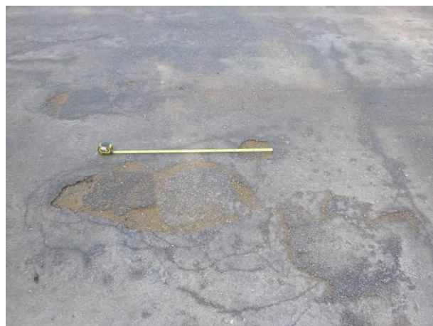
Povrch mostovky je živý s deformacemi a výtlučky.
